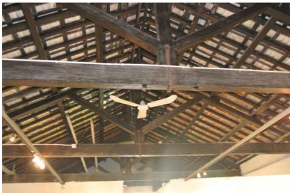
Figura 9.5.10: Estrutura com as asnas em madeira, de suporte da cobertura do Antigo Estábulo Municipal.
