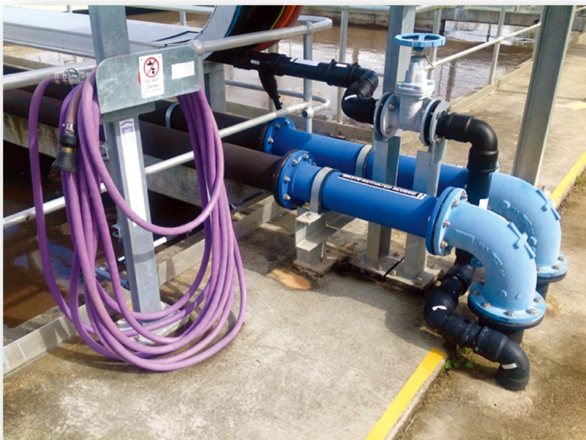
**As cores diferentes facilitam a distinção entre os tubos da água canalizada e os tubos da água reciclada.**
