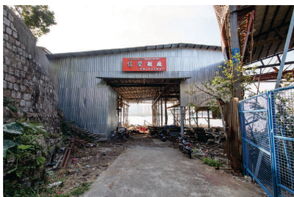
Figura 6.9: Estado do estaleiro naval n.º X-4
