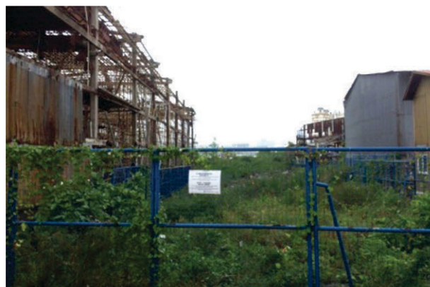
Figura 6.20: Estado do estaleiro naval n.º X-15, antes da sua demolição
