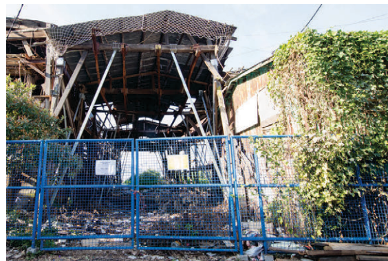
Figura 6.14: Estado do estaleiro naval n.º X-9
