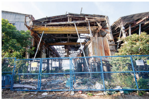
Figura 6.13: Estado do estaleiro naval n.º X-8
