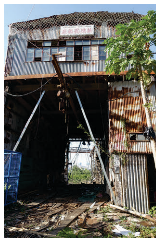
Figura 6.18: Estado do estaleiro naval n.º X-13
