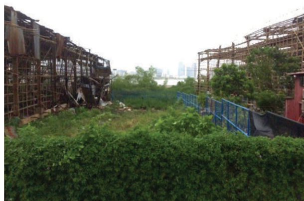
Figura 6.17: Estado do estaleiro naval n.º X-12, antes da sua demolição
