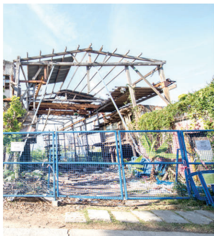
Figura 6.19: Estado do estaleiro naval n.º X-14
