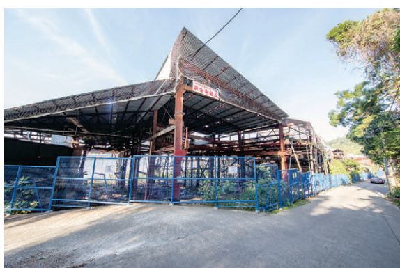
Figura 6.11: Estado do estaleiro naval n.º X-6
