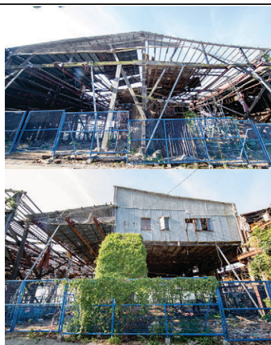
Figura 6.12: Estado do estaleiro naval n.º X-7
