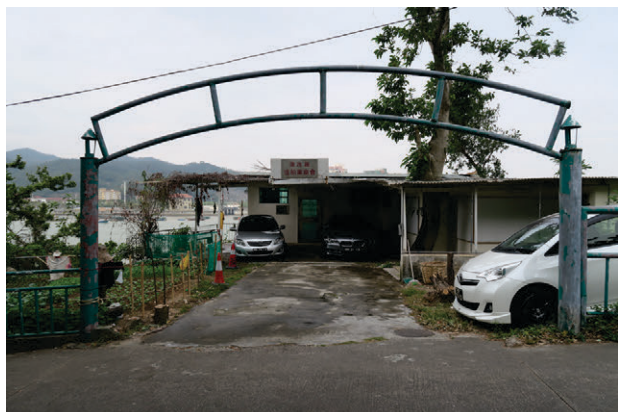
Figura 6.7: Estado do estaleiro naval n.º X-2
