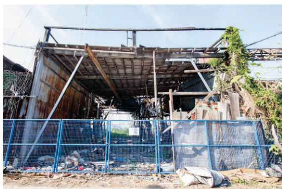
Figura 6.15: Estado do estaleiro naval n.º X-10
