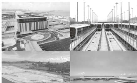
Infraestruturas concluídas no quarto mandato do Governo da RAEM
