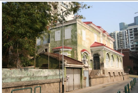
Figura 9.5.7: Perspectiva desde a Estrada Nova, vendo-se a garagem anexa, os alpendres de entrada e o acrescento construído sobre a fachada poente.
