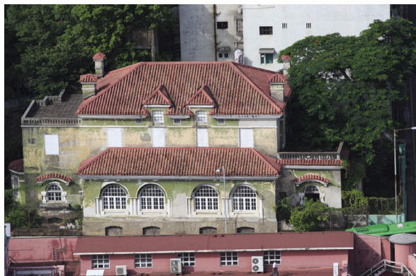
Figura 9.5.8: Perspectiva aérea do edifício, vendo-se a configuração dos telhados e mansardas típicas da arquitectura portuguesa, bem como o volume acrescentado na fachada poente.
