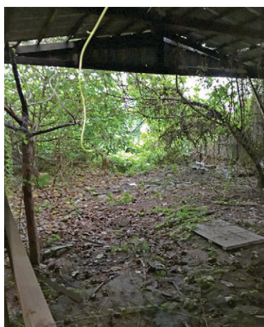
圖 6.23：無門牌之船廠的近況。
