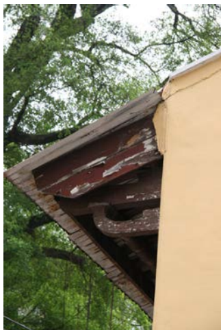
圖 6.5.8：龍嵩正街 47 號房屋的中式木構斗拱。
