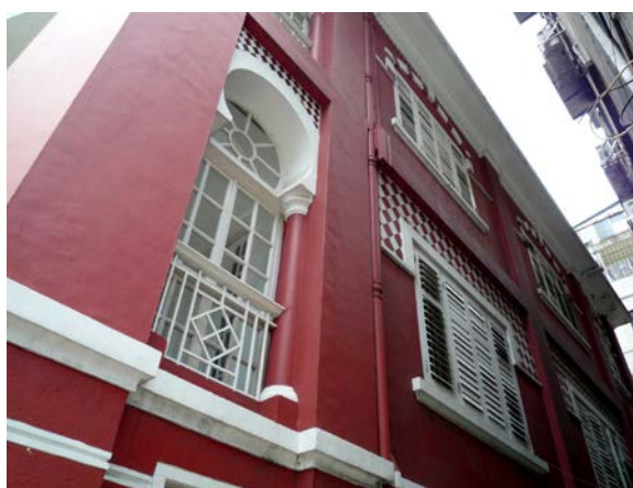
圖 4.5.6：東望洋斜巷 6 號房屋側立面。
