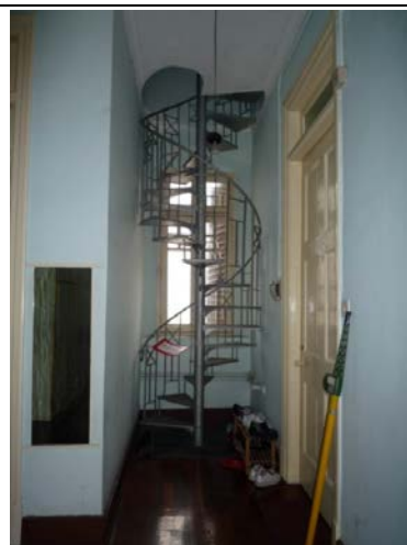
圖 5.5.6：通往屋頂的室內螺旋鐵梯。
